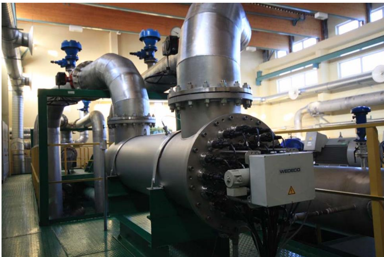
Рисунок 8. Система УФ обеззараживания
